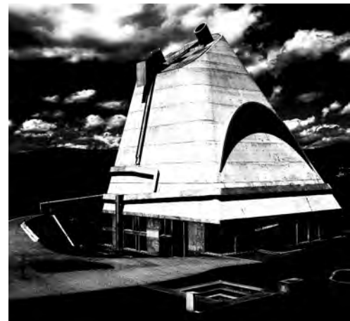
L'église terminée en 2006 : miracle !
